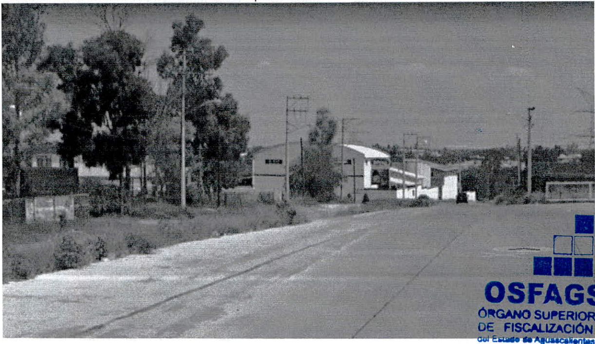
Previo al inicio de construcción de la calzada poniente.
